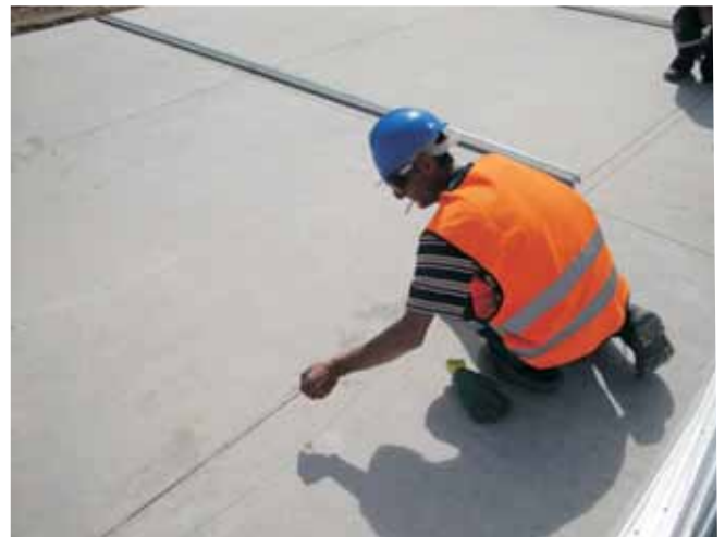
Se marca sobre la platea la posición de cada uno de los muros
