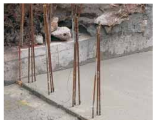
Anclajes previstos antes del llenado
