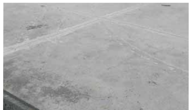
Losa de fundación luego del fraguado
