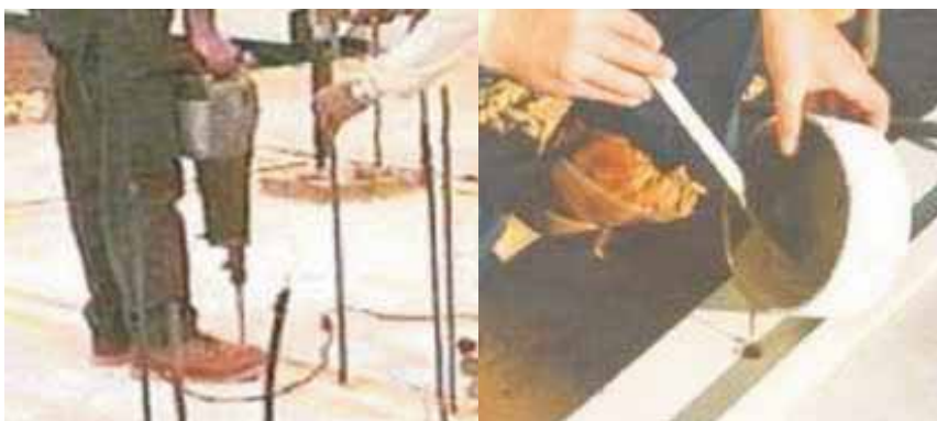
Colocación de anclajes con soldadura química luego del llenado de la platea
