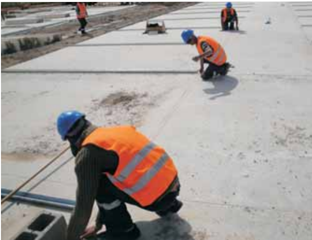
Se marca sobre la platea la posición de cada uno de los muros
