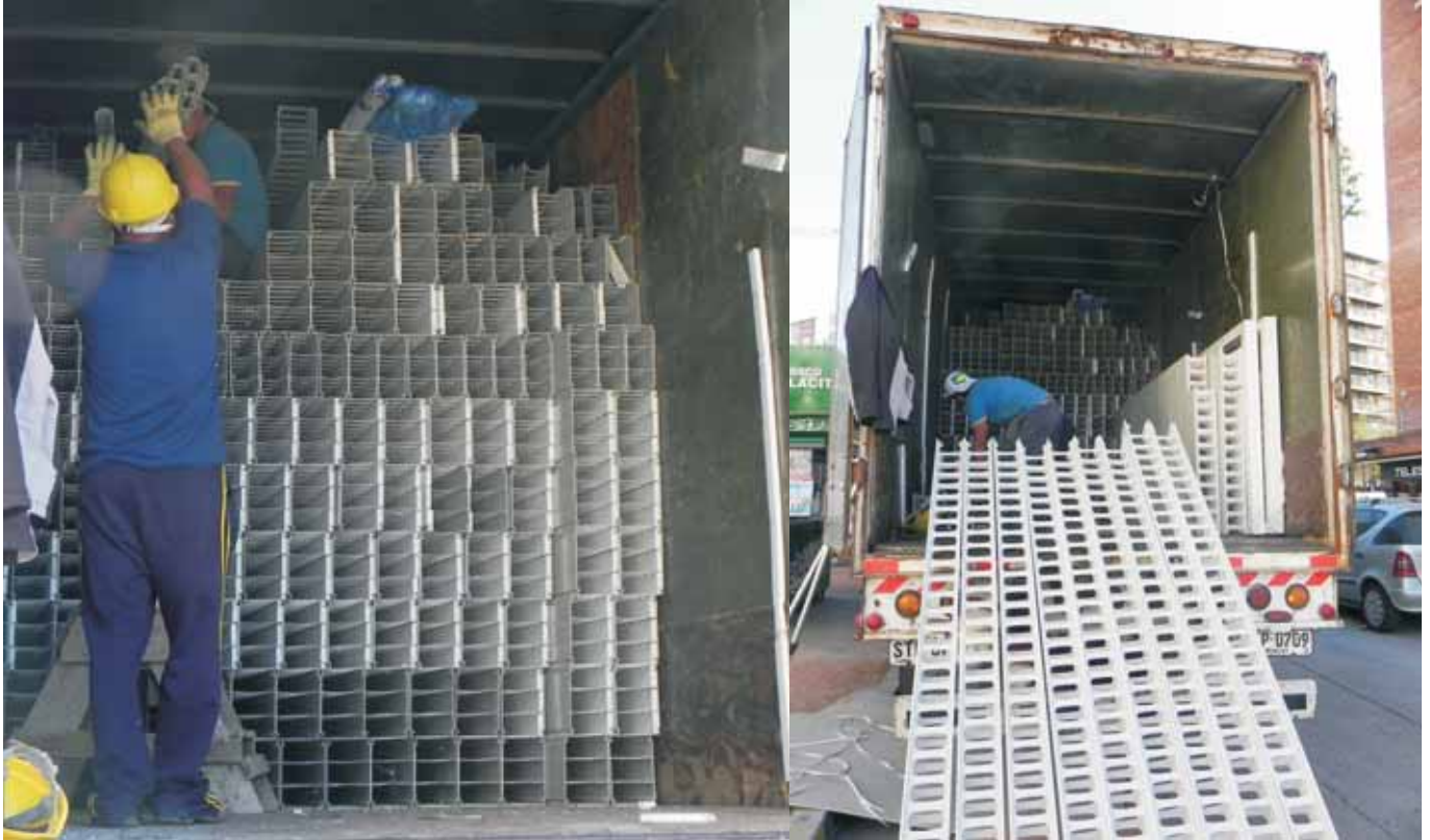
llegada de camión a pie de obra
