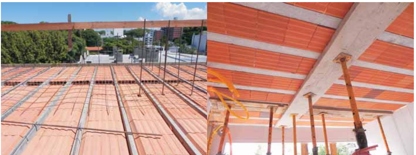
ejemplo de entrepiso con vigueta y bovedilla cerámica
