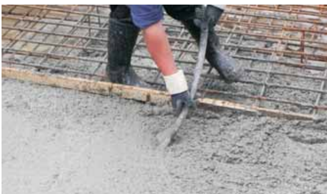
Vibrado losa de fundación durante llenado
