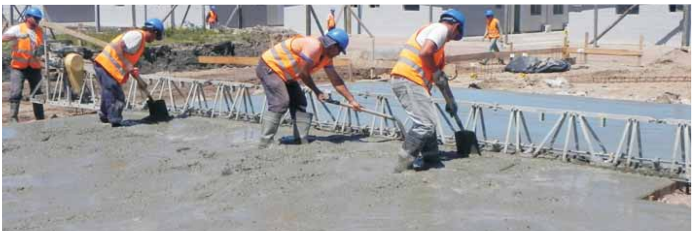
Llenado manual losa de fundación
