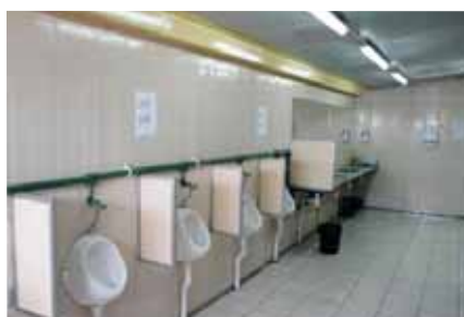
Carpintería y terminaciones
