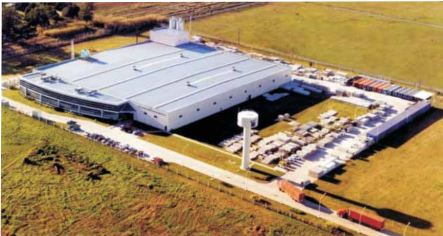
Foto aérea Planta Industrial RBS Ruta 2, km 55 y Av. 520 B1903 CPB Abasto Provincia de Buenos Aires - Argentina
