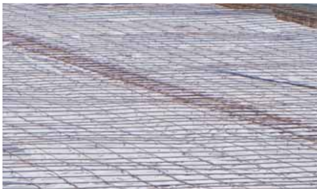
Malla electrosoldada sobre film de polietileno
