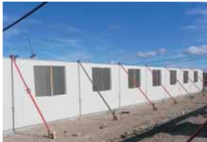
Ensamble y aplomado de muros
