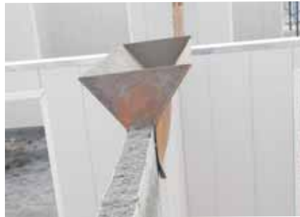
Relleno de paneles
