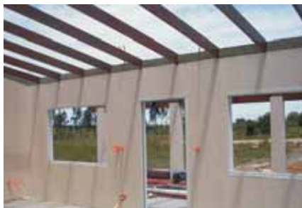
Montaje de Techos
